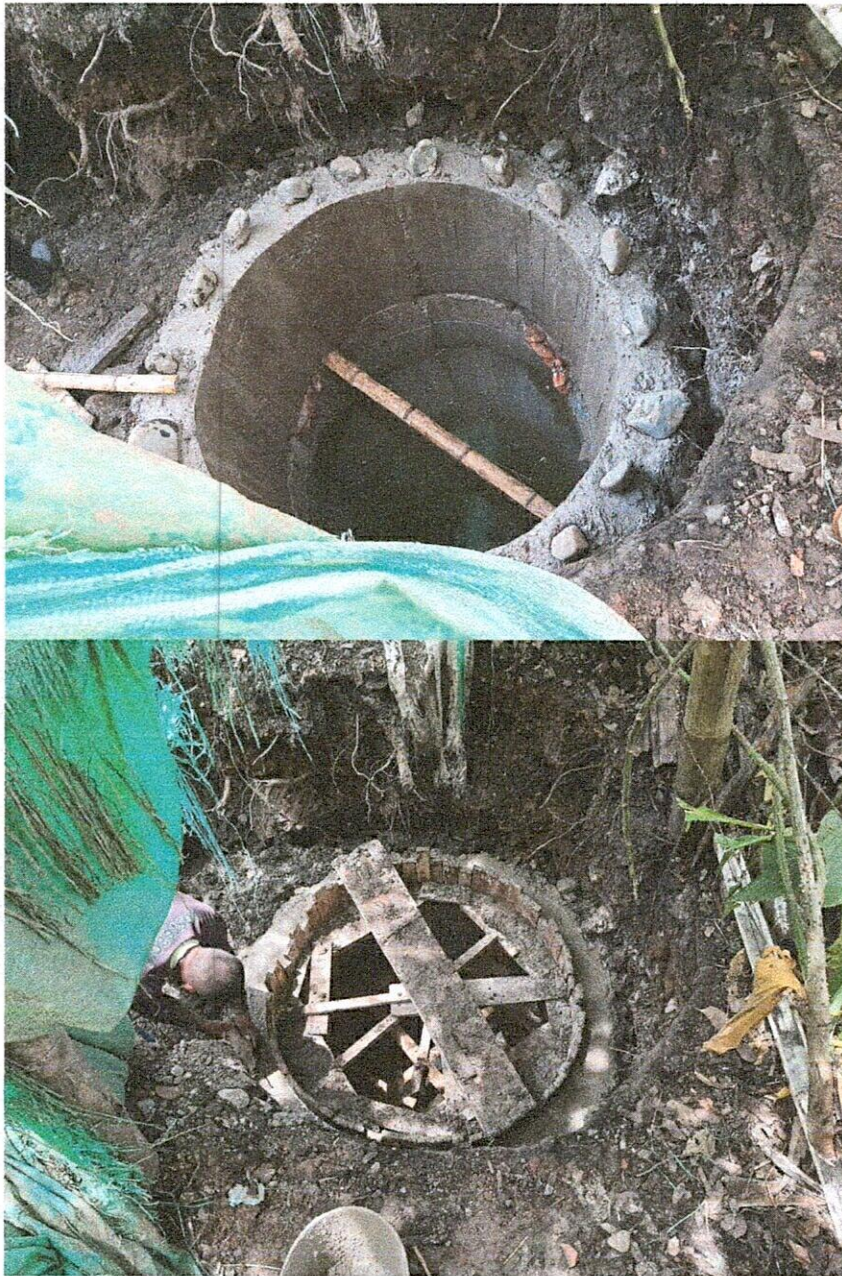
Instalación tubería caudal de alivio
