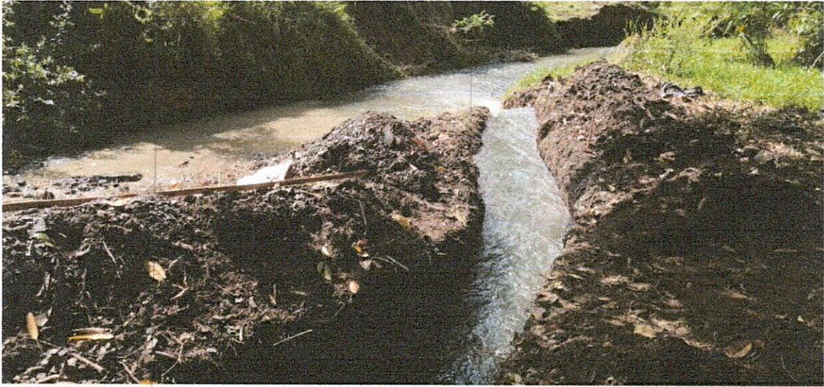
INSTALACION DE TUBERIA PASO SUBFLUVIAL
