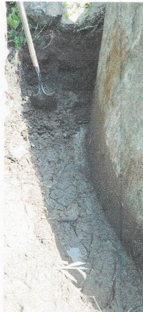
Excavaciones al exterior para la impermeabilización
