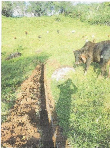
Instalación de tubería de 2", excavaciones y uniones
