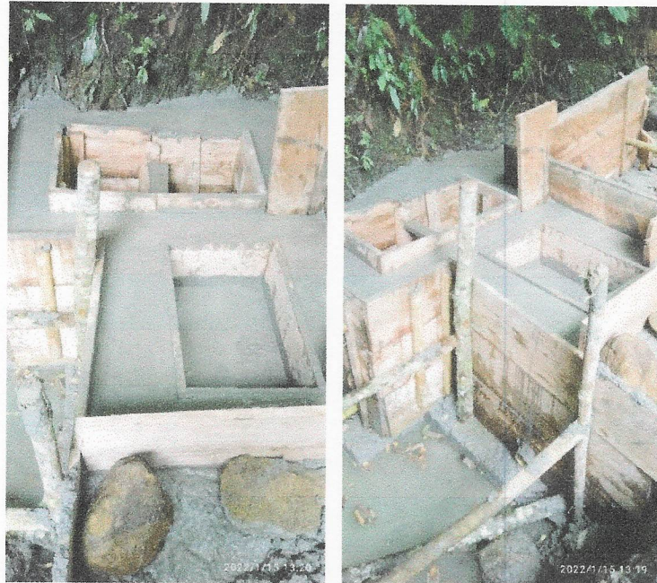
Proceso constructivo bocatoma.
