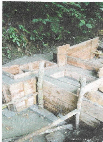
Bocatoma construida
