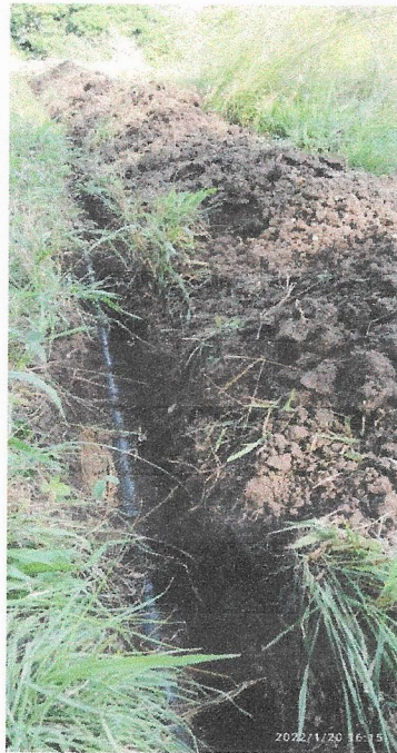
Instalación de tubería de 2" excavaciones y reposición
