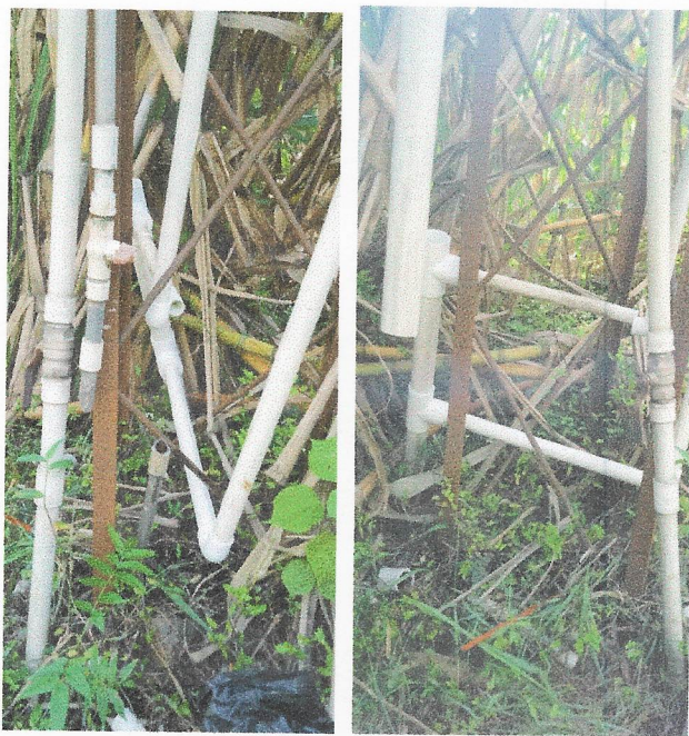
Conexiones adicionales para habilitar tanque auxiliar privado para no dejar la comunidad sin agua
