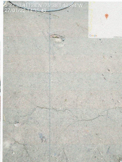
Estado del tanque, muestra grietas y desprendimiento de concreto
