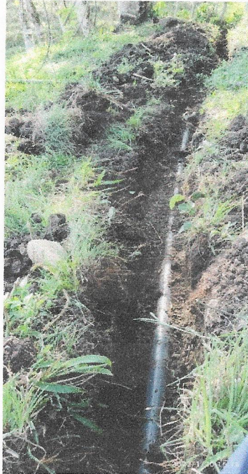
Instalación de tubería de 2" excavaciones y llenos
