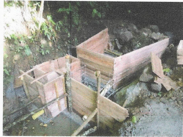
Formaleta, aceros y construcción de bocatoma en concreto reforzado
