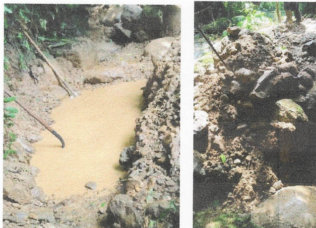
Excavaciones y desviación del cauce
