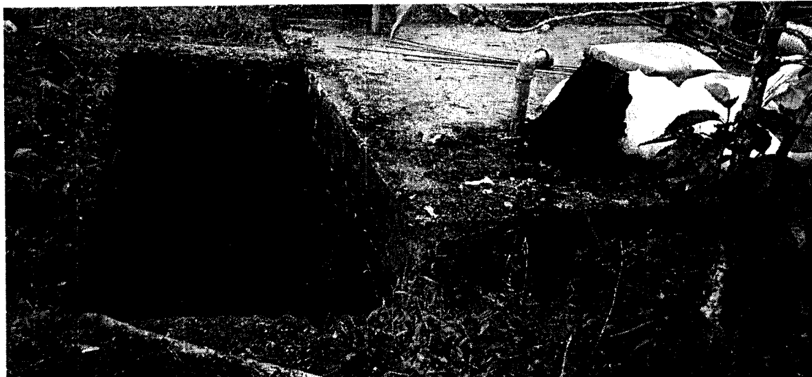
Excavaciones para construcción de desarenador.
