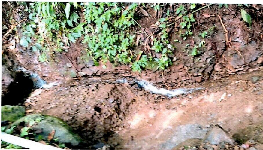
Excavaciones para construcción de desarenador
