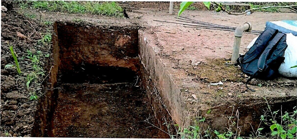
Excavaciones para construcción de desarenador.
