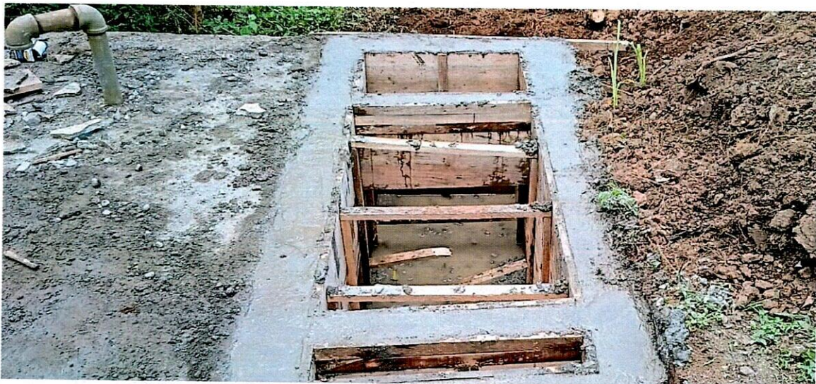
Proceso constructivo desarenador
