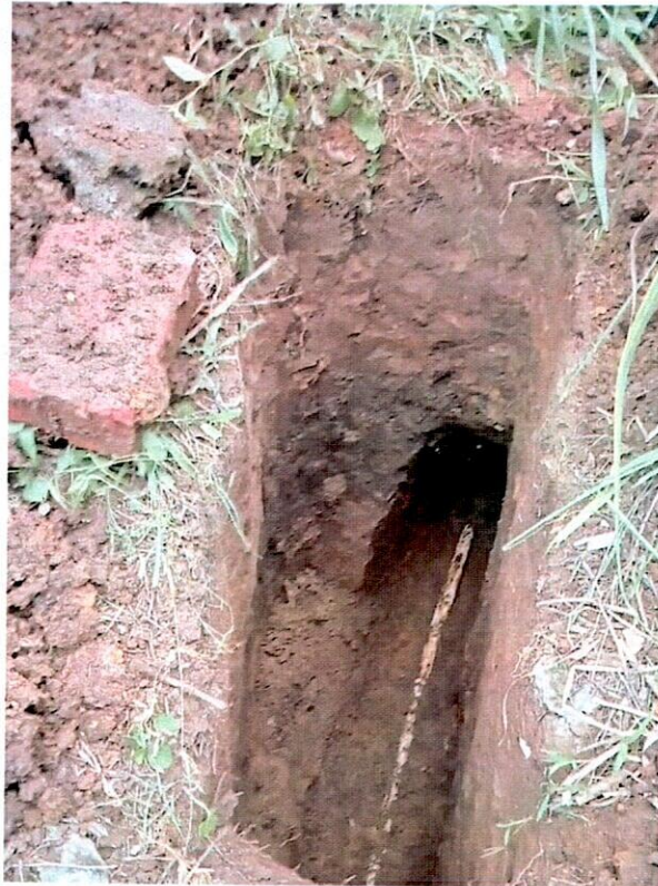
Proceso de excavación e instalación de tubería de presión de 2”.
