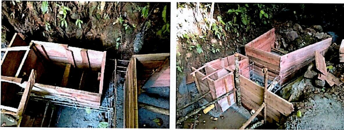
Formaleta, aceros y reconstrucción de bocatoma en concreto reforzado.
