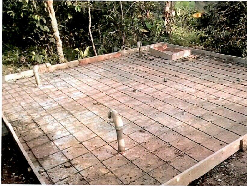
Reforzamiento tapa de tanque.
