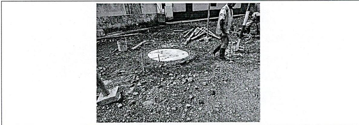
1.5 Suministro e instalación filtro drenaje (0.5x0.2 m), incluye relleno piedra filtro, geotextil nt 2000: a partir de la cámara de inspección N°4 hasta la cámara de inspección N°7 se hace necesario construir un filtro paralelo a la red, dada la gran cantidad de agua que por escorrentía superficial y por infiltración, están llegando a la red. Este filtro se conectará a una caja de inspección que se ubica cerca de la cámara de inspección N°7 y de allí con el descole de aguas lluvias existente.
