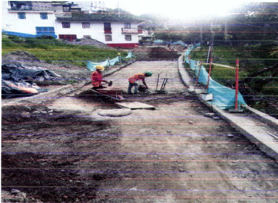
Cerramiento con tela verde y soportes de guadua cada 2 metros
