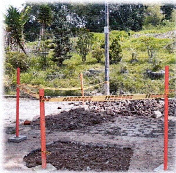
IMAGEN 7: SEÑALIZACION EN OBRA
