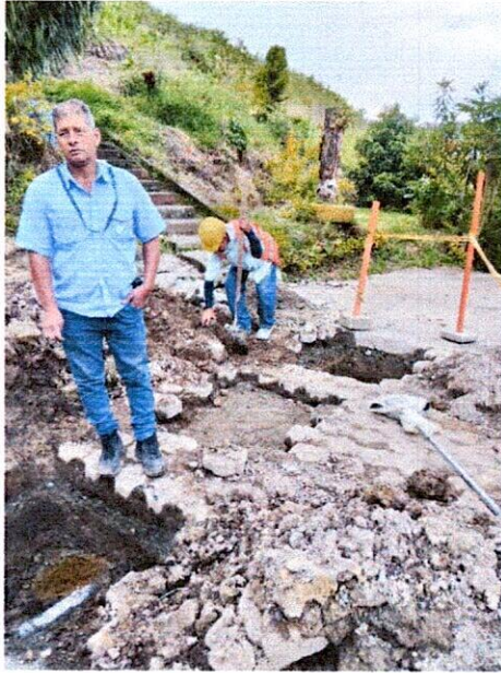
FOTO 7. Apiques para ubicación de tubería de acueducto existente para instalación de válvula
