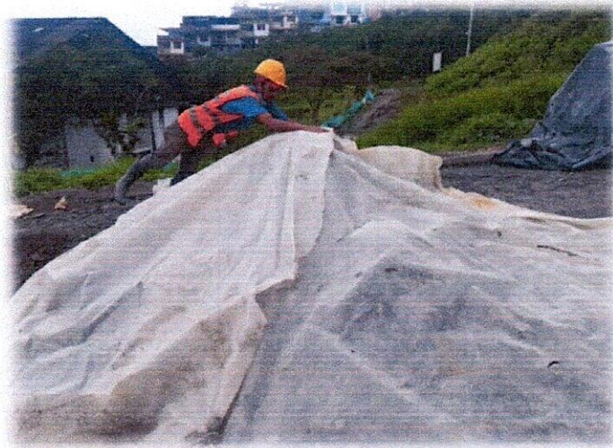
IMAGEN 3: ACOPIO MATERIAL PROTEGIDO
