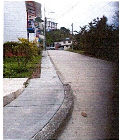
FOTO 2. Concreto de 21Mpa para graderías, andenes y sardinel incluye formaleta
