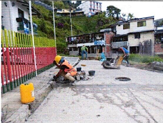
FOTO 7. Apiques para ubicación de tubería de acueducto existente para instalación de válvula
