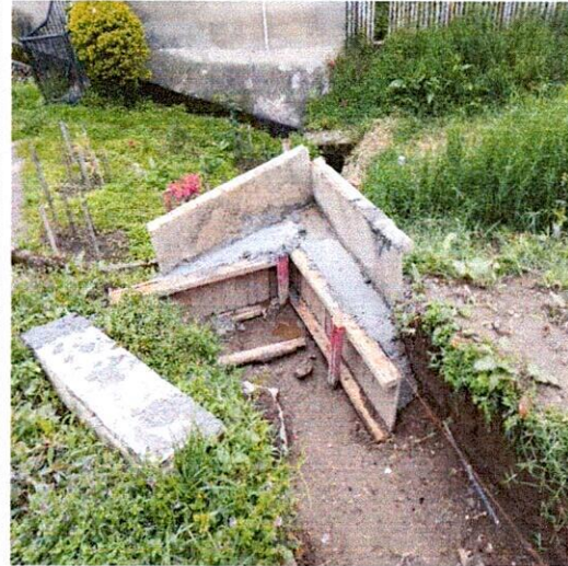
FOTO 8. Empalme de tubería existente con la nueva tubería de acueducto de 3"
