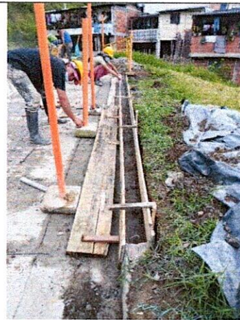
FOTO 10. Construcción de cunetas
