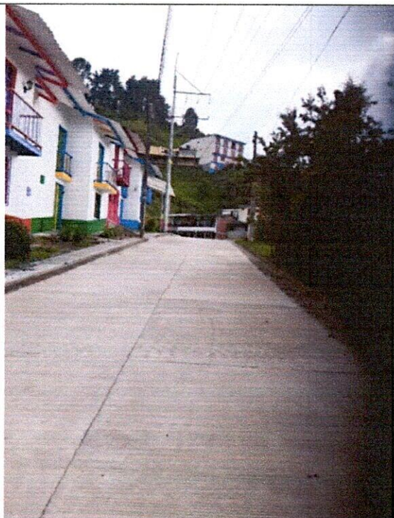
FOTO 3. Concreto para pavimento 42MR hecho en obra incluye formaleta y sardineles
