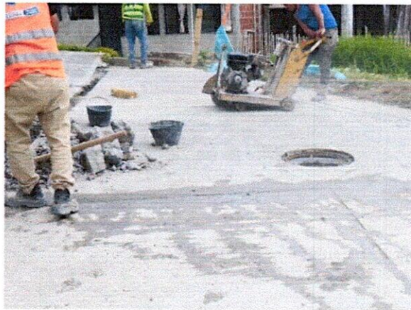
FOTO 1. Corte con disco Abrasivo para dilataciones incluye sello elastomérico
