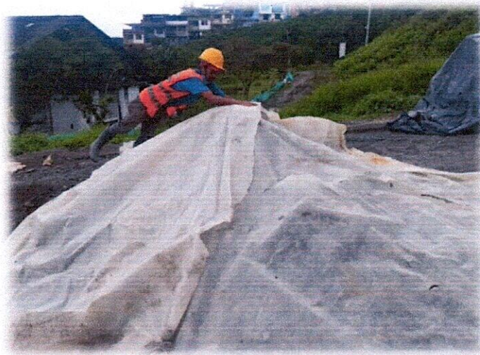
IMAGEN 3: ACOPIO MATERIAL PROTEGIDO
