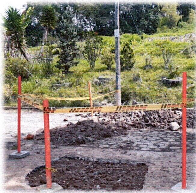
IMAGEN 7: SEÑALIZACION EN OBRA
