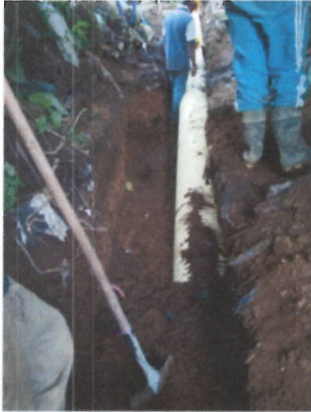
INSTALACIÓN DE TUBERÍA DE 18"
