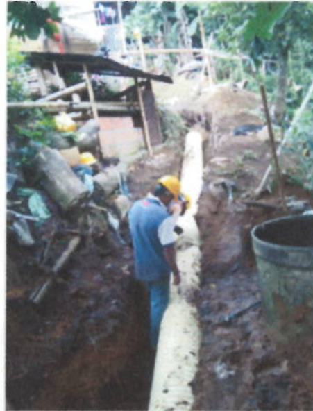
INSTALACIÓN DE TUBERÍA DE 18"
