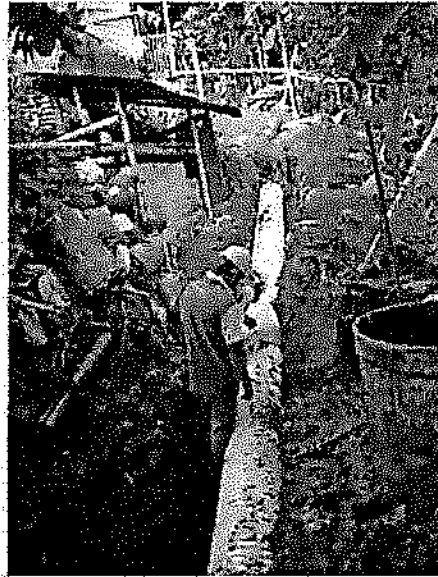
INSTALACIÓN DE TUBERÍA DE 18"
