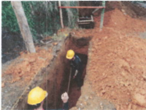
EXCAVACIONES EN ZANJA
