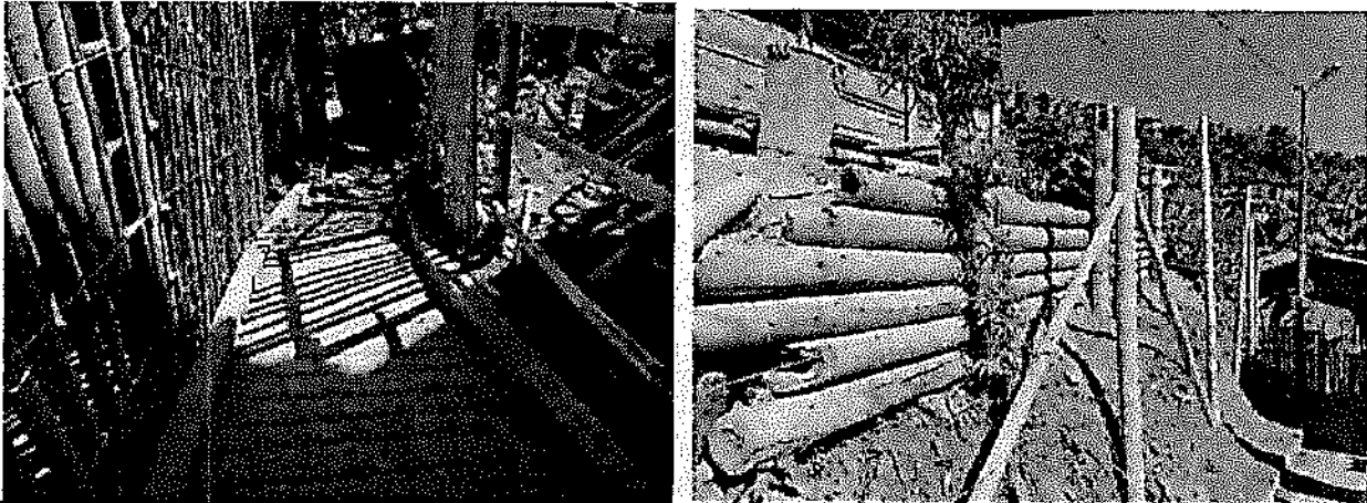
REPOSICIÓN DE CERRAMIENTOS EN GUADUA Y ALAMBRE DE PUA
