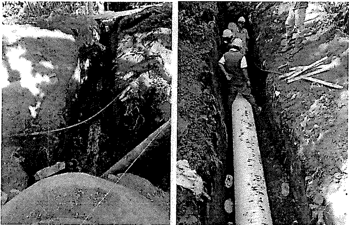
INSTALACIÓN DE TUBERÍA
